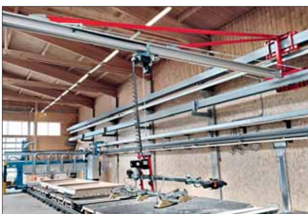
Die Kraninstallation des „WPC“ wurde seitlich an der Hallenkonstruktion befestigt ...
